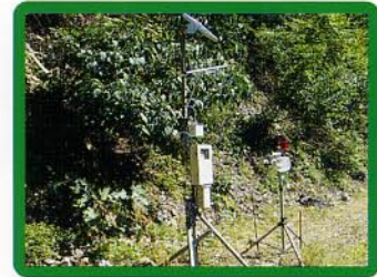
受信器の設置状況
